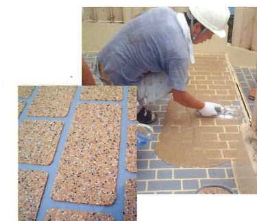
標準型枠施工例
