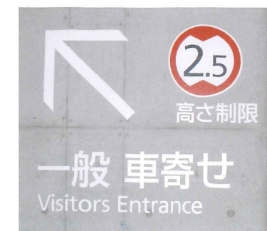
標識型枠施工例
