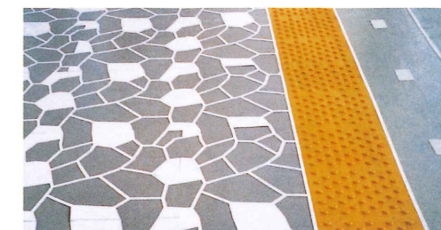
点字型枠と標準型枠で仕上げた鉄平石パターン
